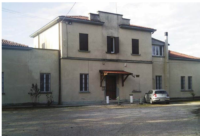
FACCIATA ESTERNA DEL TIRO A SEGNO
